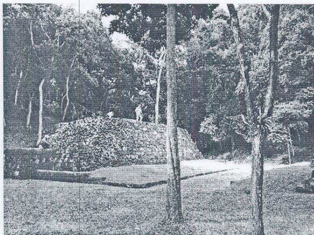
Foto 4. Juego de Pelota I durante los trabajos de conservación
